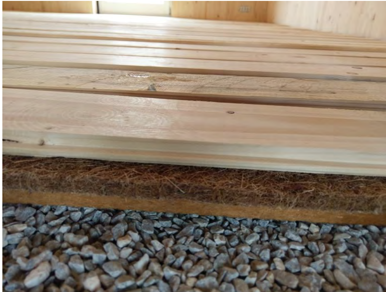
Bodenaufbau mit Trittschallschutz im OG
